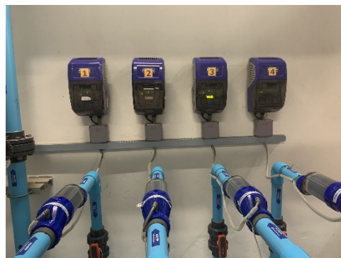
ภาพที่ 3 แสดงเครื่องผลิตคลอรีนจากเกลือ 01 ถึง 04
