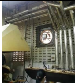
ภาพที่ 4 ตัวดูดอากาศที่ถูกติดตั้งภายในแผนกซักกริด
