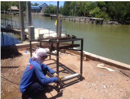
ภาพที่ 3 ขึ้นโครงเหล็ก
