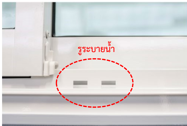
ภาพที่ 2 การเจาะรูที่ขอบรางของหน้าต่างรหัส W0023s ที่มา โสมดีดี. (2566)
