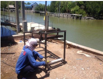
ภาพที่ 3 ขึ้นโครงเหล็ก
