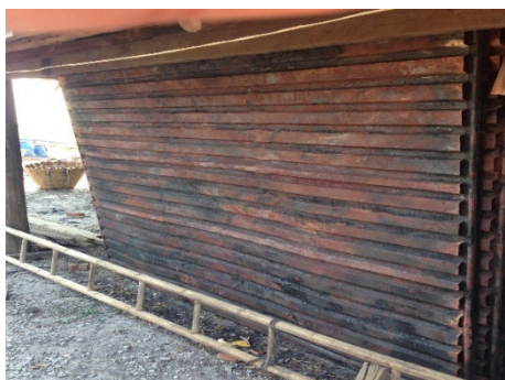
ภาพที่ 8 แผ่นผนังเตาแบบเดิมที่มีลักษณะเป็นร่องแนวขวาง
