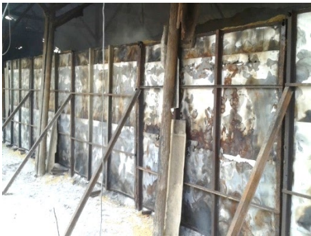
ภาพที่ 10 การใช้งานแผ่นผนังเตาแบบปรับปรุง
