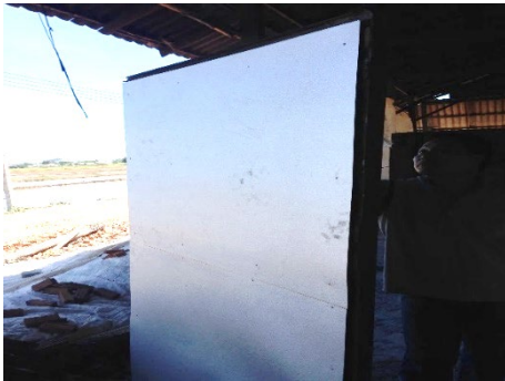
ภาพที่ 9 ลักษณะแผ่นผนังเตาที่ดำเนินการปรับปรุง
